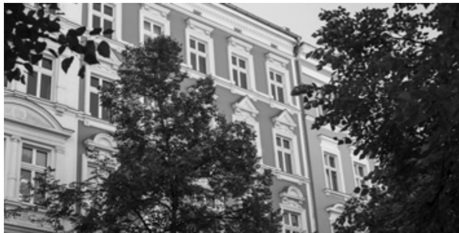
Sanierte Altbauten führen zu Mietpreissteigerungen.
